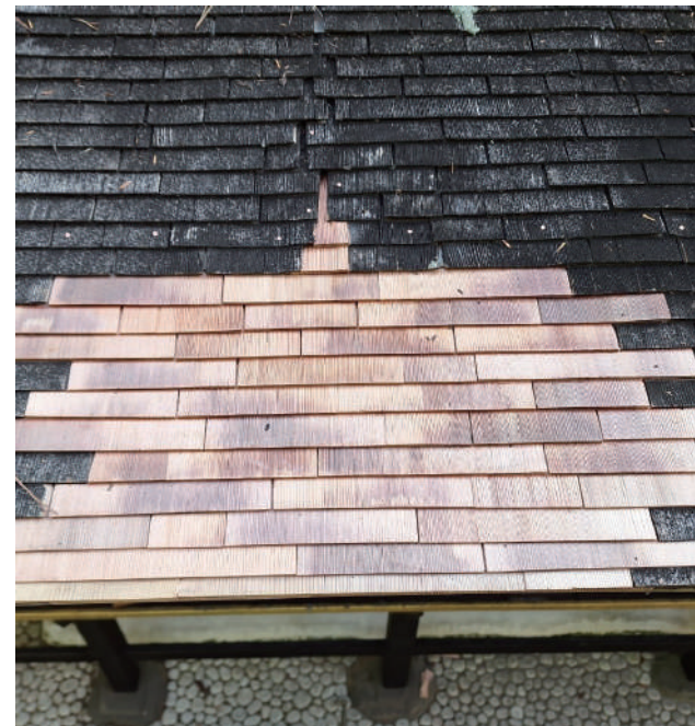
御社殿屋根損傷状況
