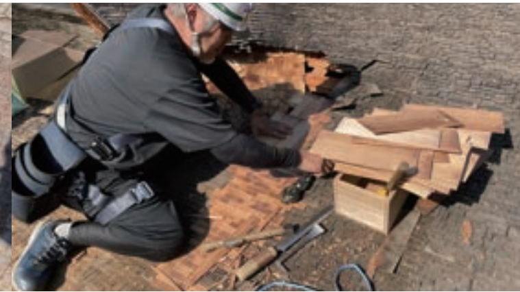
柿葺きにて補修
