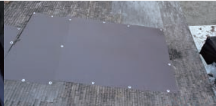
鉄板にて補修
