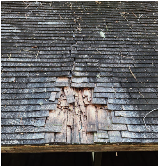
御社殿屋根損傷状況
