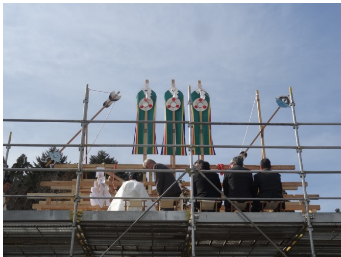
御社殿上棟奉告祭②
